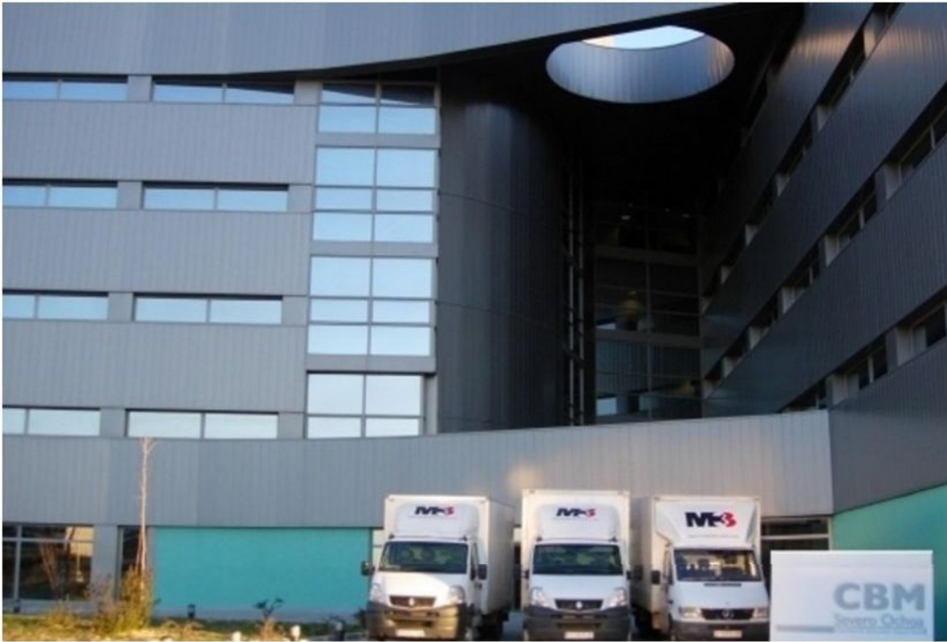
CBMSO INSTALACIÓN DE 1700 METROS LINEALES DE LABORATORIO
